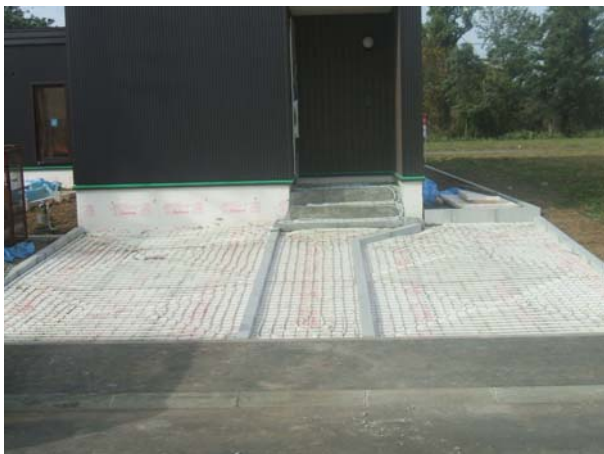
Fig. 4.3 ヒーティング配管
